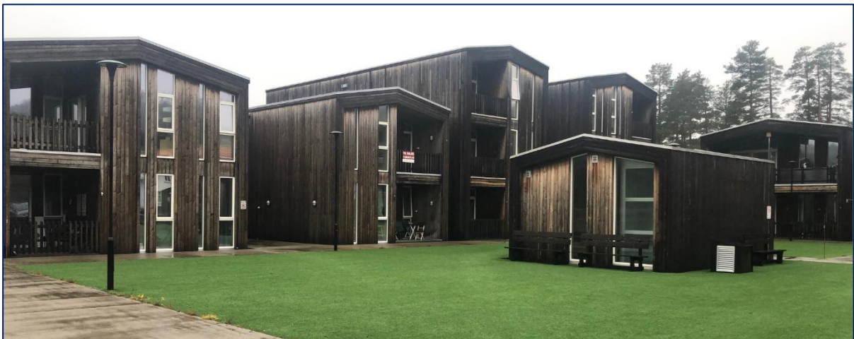
Aldersvennlige og stedstilpassede boliger i Iveland sentrum (foto: Husbanken)
