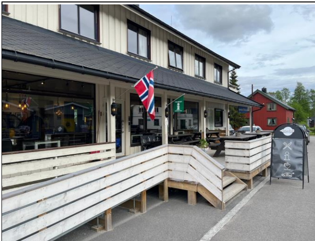
Engerdal torg: Ombygging av eksisterende bygg i 2019 med turistkontor, kafé mv i første etasje og leiligheter i andre etasje
