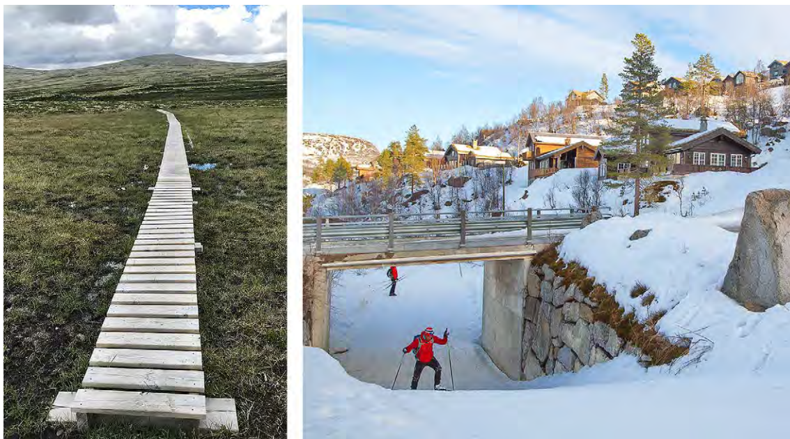
Til venstre: Klopping i Rondane nasjonalpark for å avgrense slitasjen over myr. Til høgre: Planskilt kryssing av køyreveg for å vareta trafikktryggleiken for skiløparar.
