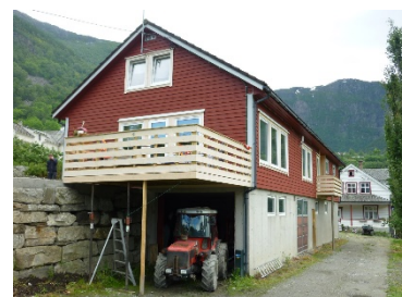
Ombygd driftsbygning til leiligheter, Ullensvang
