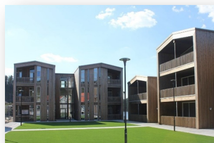
Åkle leilighetsprosjekt, Iveland
