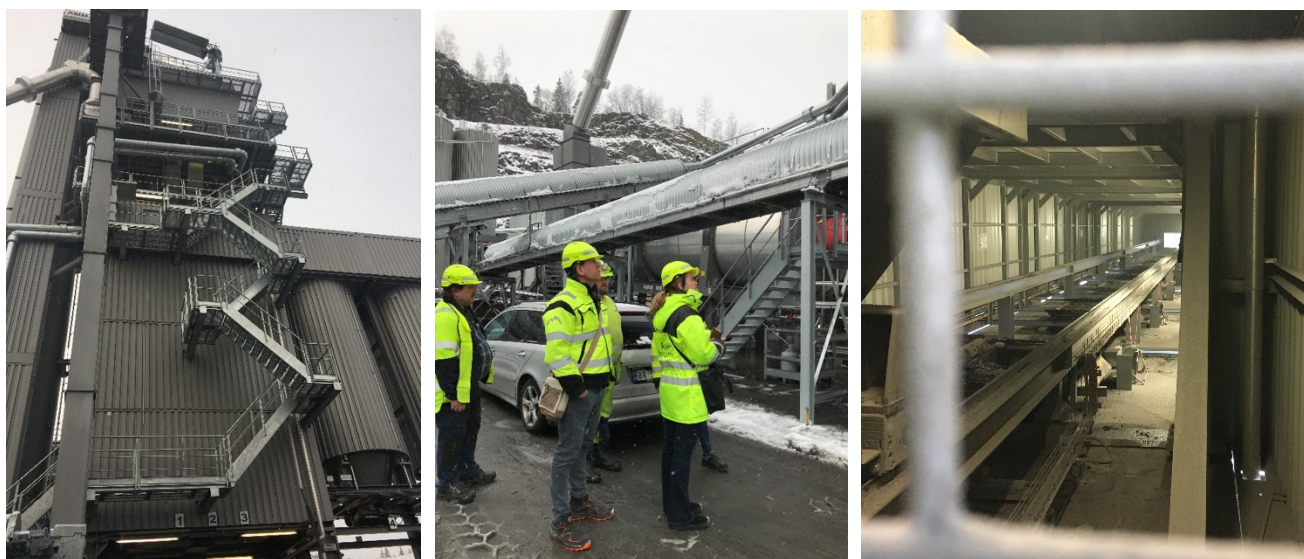
Bilde 2-4: Fra befaring på asfaltfabrikk.
