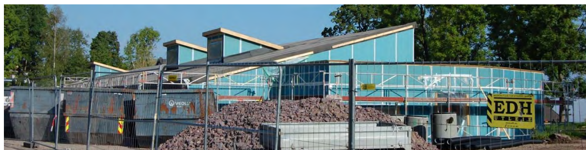
Kleiverud barnehage under bygging – ble åpnet våren 2015
