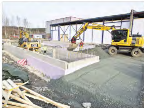
BYGGER UT: Selska AS, som skal lage supper og saus for matvarebutikker og spesialforretninger, bygger om og bygger ut Jødråkkolene på Siva i Kongsvinger.
