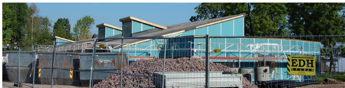
Kleiverud barnehage under bygging – ble åpnet våren 2015
