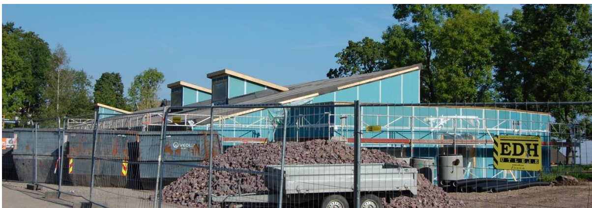
Kleiverud barnehage under bygging – ble åpnet våren 2015
