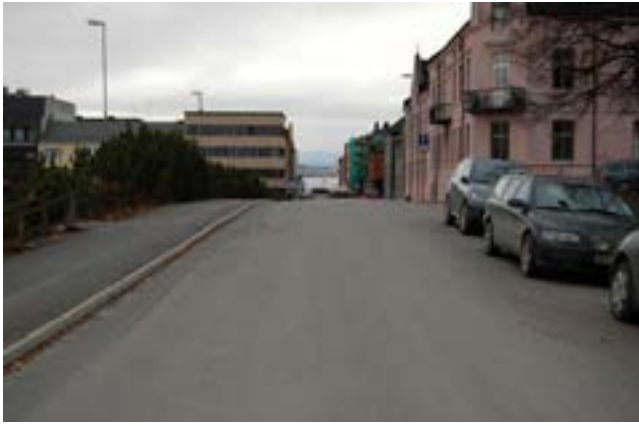
Bildet viser Håkonsgate før noe ble gjort.
