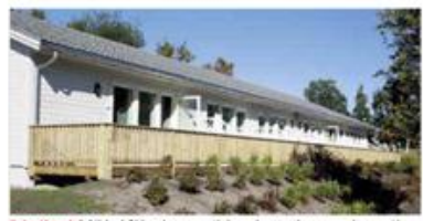
Privatbygd: I Gildeskål har høgare utleieprisar og kommunal garanti fått private til å bygge utleigebustader.
