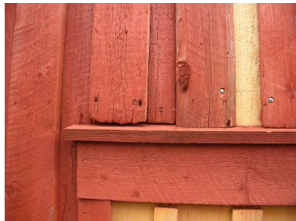
Detalj fra restaureringen i Skjærvær. Et viktig prinsipp er at det skal se ekte ut. Da kan kun de råtne bordene skiftes.
