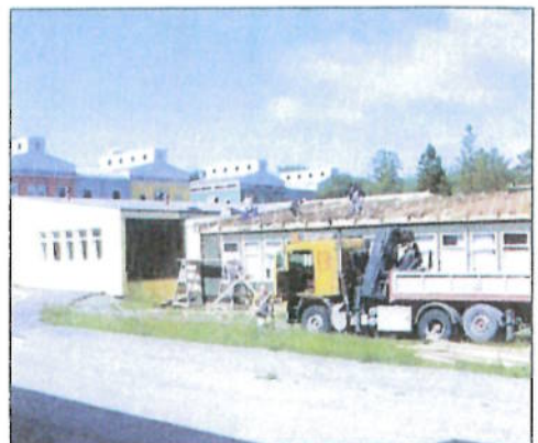
Rivinga er i gang i godveret. Nå skal den gamle skolefløya på Stokmarknes ved Neshallen og busstoppet vekk. (Foto Solgunn Jensen)
