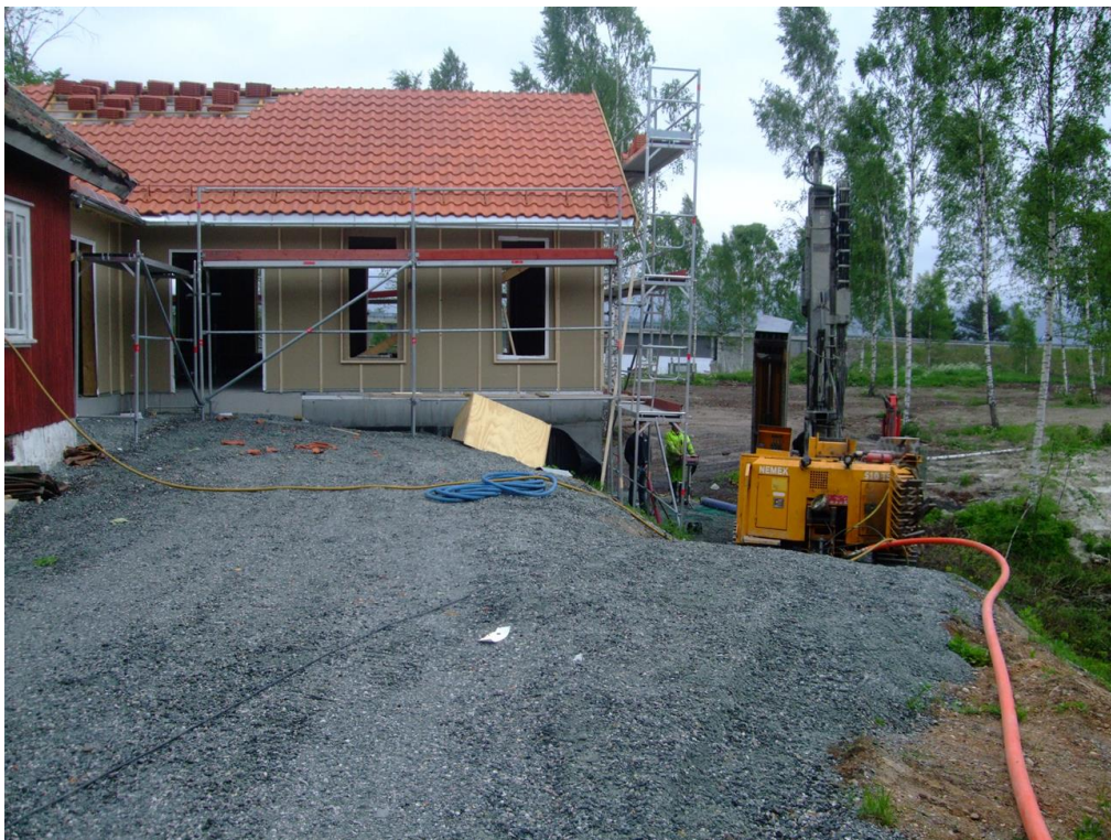
5 Nybygget varmes opp med grunnvarme
