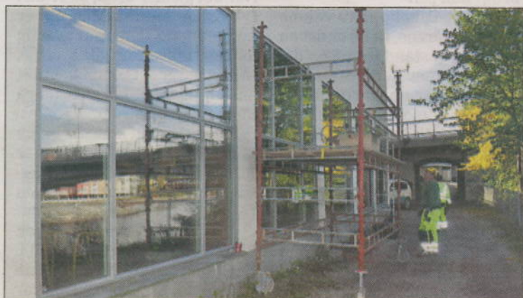
PÅ Plass: De seks store vinduene ut mot elva og de fem vinduene ut mot torget er skiftet ut.
